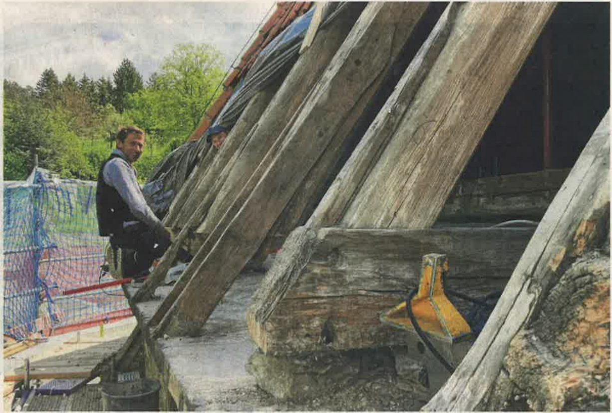
Die Zimmermänner Markus Trupp (rechts) und Stefan Kluge bei den Arbeiten am Dachstuhl der Ziegenhainer Kirche. Weitere Bilder von der Sanierung unter www.otz.de/jena
