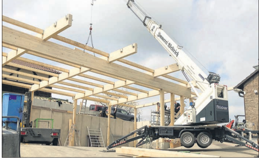
Neubau Halle Firmengrundstück. Foto: Zimmerei Weltrich
